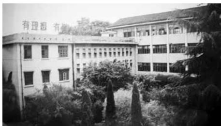
1990年4月竣工、位于学校教学区东南侧的图书馆
