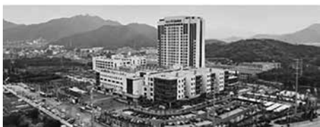
位于中兴南路上的学校新附属医院院区设施全景
