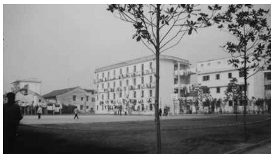
1977年6月，绍兴卫校八字桥校园生活区竣工的第1幢四层砖混结构学生宿舍大楼
