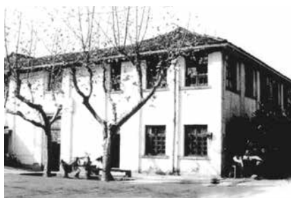
绍兴卫校总部在东街路校区内的2层教学楼（1951年建）
